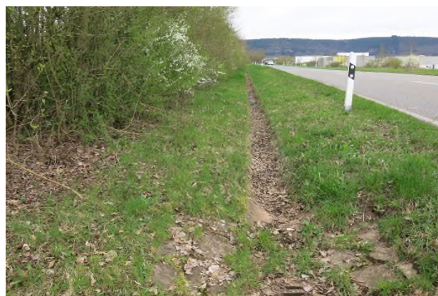
Foto 7: L 48 mit straßenseitigem Rain, Betonrinne und Gehölzstreifen
