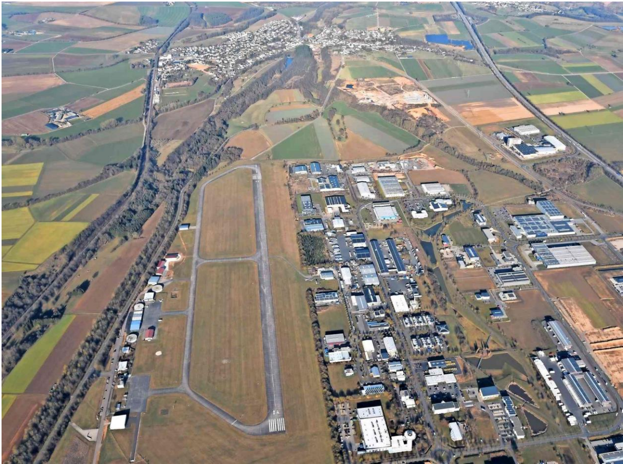
Der Industriepark Region Trier (rechts im Bild) soll in Richtung der Ortsgemeinde Hetzerath (oben im Bild) erweitert werden. Foto: Portaflug
