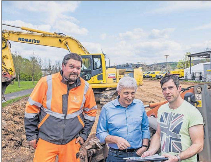
In der Europaallee 8 wird fleißig an der Erweiterung des Gebäudekomplexes gebaut. In der Mitte IRT Geschäftsführer Reinhard Müller.
